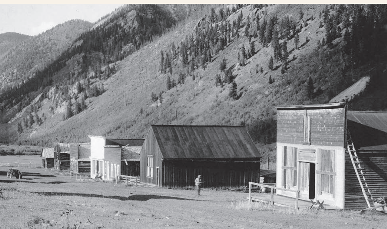
Falso frente en los edificios a lo largo de Castle Avenue.
