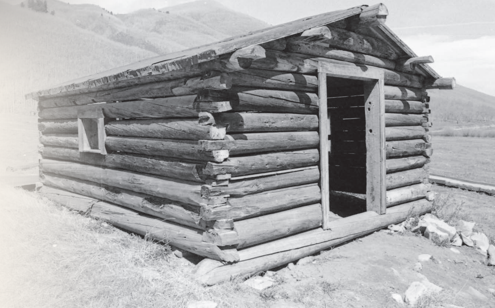
Una cabaña de herrero se puede identificar por la puerta de gran tamaño, que permitía el acceso de los caballos para el herraje.
