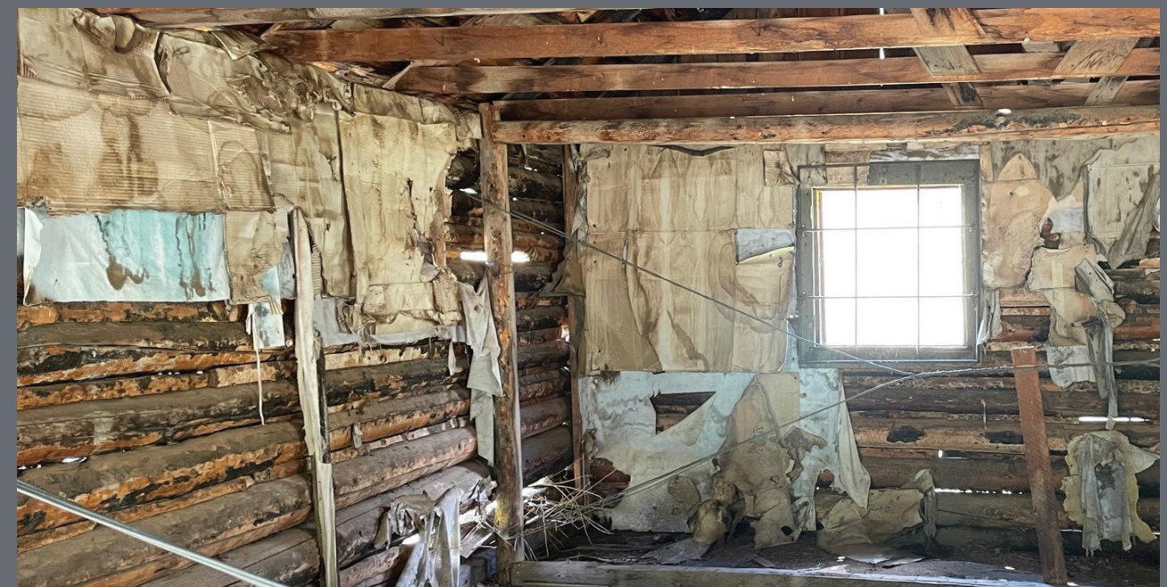
Los residentes de esta cabaña intentaron detener las corrientes de aire usando tela pintada con encalado azul. Más tarde se agregó una capa de cartón. Esta cabaña originalmente tenía un piso de madera.
