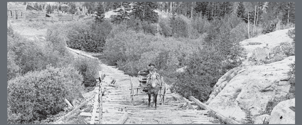
Camino construido con troncos en una zona pantanosa.
