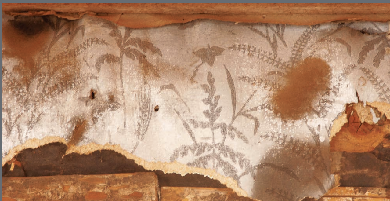
El papel tapiz cumplía una doble función: embellecer los interiores y actuar como aislante.
