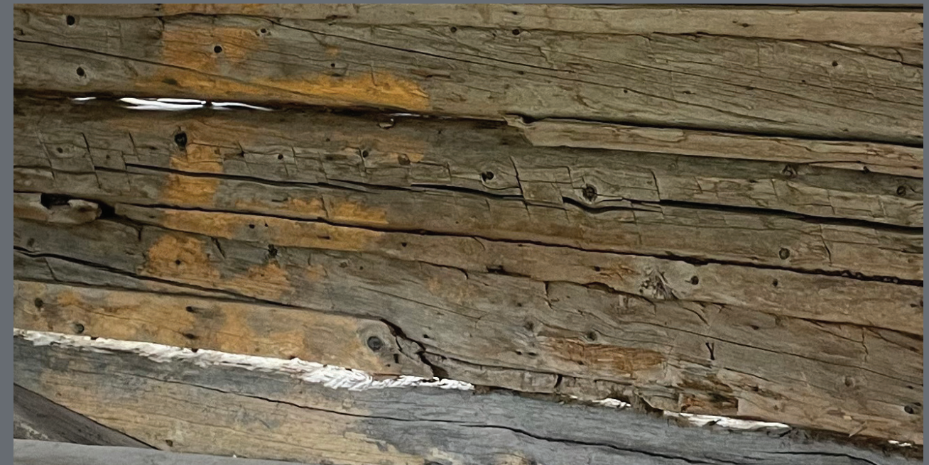
Antes de que se abrieran aserraderos en los bosques circundantes, las cabañas se construían de troncos labrados a mano. Las marcas de hacha distintivas (que se muestran aquí) son visibles en el tronco más bajo de este edificio.
